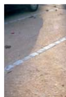
Parking en béton désactivé et calcaire
