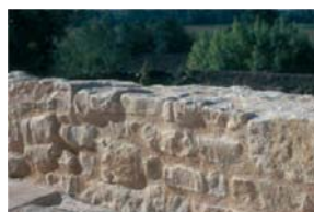
Muret en moellons de pierre
