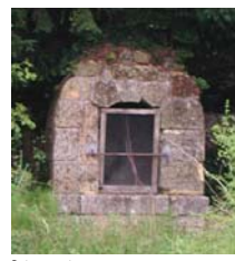
Puits en pierre
