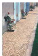
Trottoir en béton désactivé et calcaire
