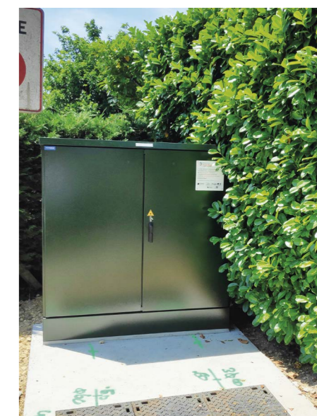
Installation d'armoires « haut débit » dans le cadre de l'arrivée de la fibre
