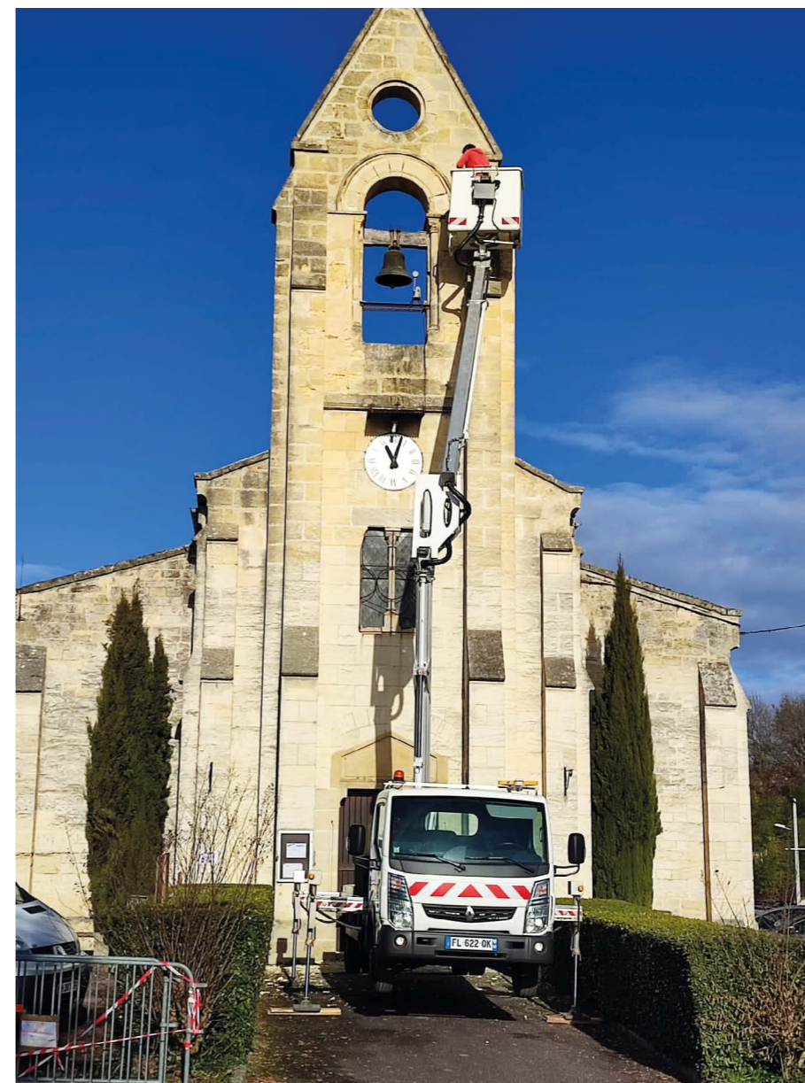
Réparation façade et clocher de l'église
